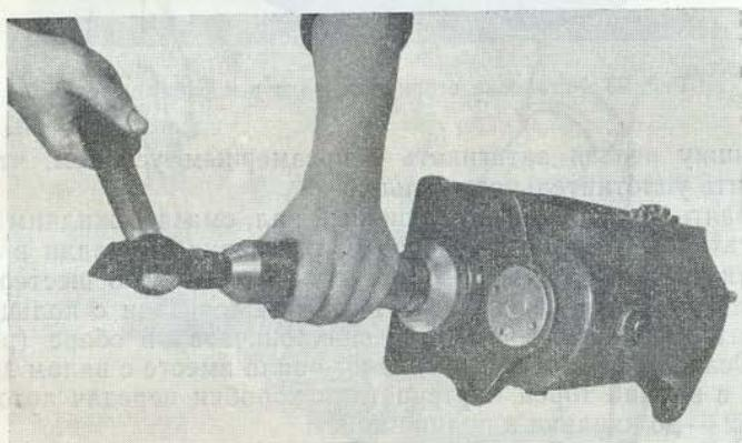
Рис. 95. Установка первичного вала в коробку передач
