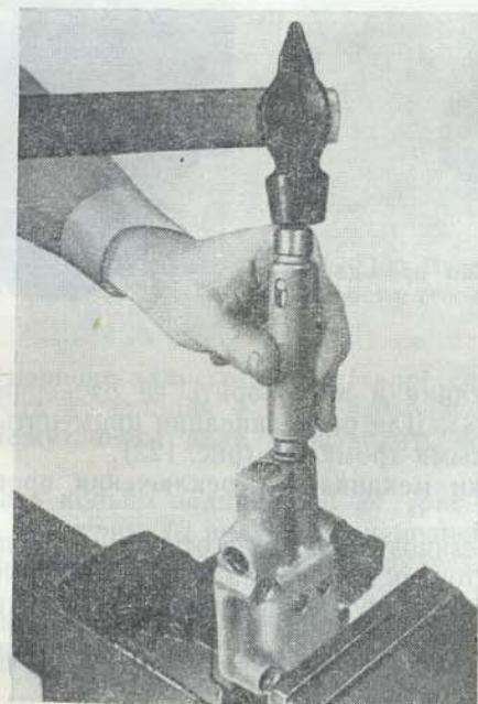
Рис. 125. Расчеканка заглушек отверстий штоков
